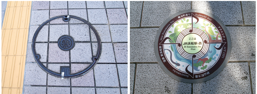
▲ 바닥마감과 어울리도록 맨홀을 설치한 예
