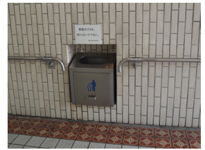
휴지통 지하도의 휴지통은 홈을 파서 설치 하여 보행자를 방해하지 않도록 하 고 있다.
