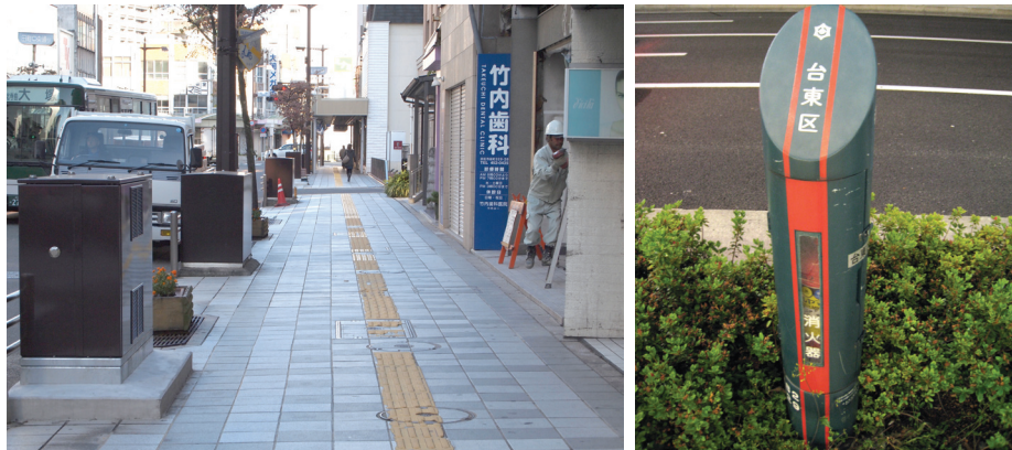
▲ 보행장애물 존에 설치한 배전함 등의 설치 예
