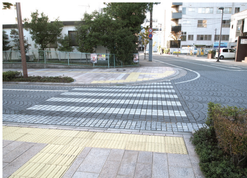
▲ 차량의 과속을 억제하는 요철포장의 설치 예
