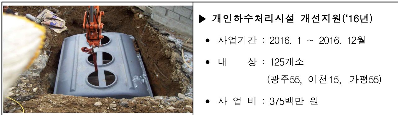
< 그림 2-4-10 > 개인하수처리시설 설치 장면
