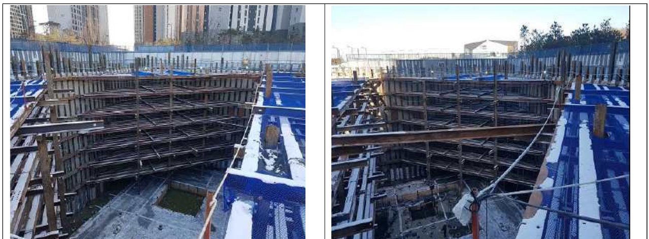
그림 3.8 굴착 단면도(7단 하부 과굴착 사진)
