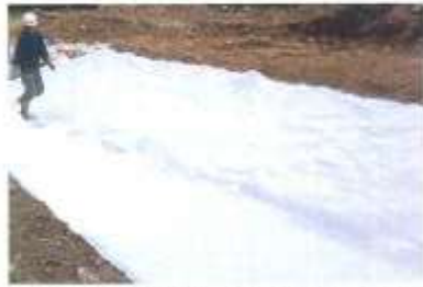
① 사면정리 및 부직포 설치
