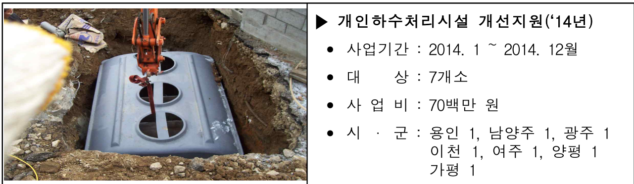
< 그림 2-4-10 > 개인하수처리시설 설치 장면
