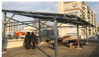
태양광 설치 지원
