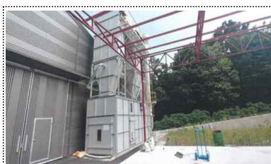
환경오염방지시설 설치 등 용자지원사업(방지시설 설치)
